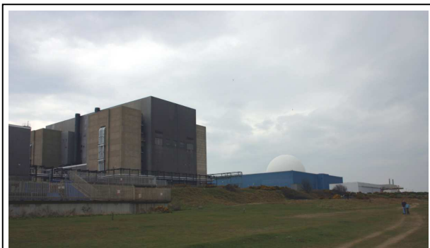
Minulost a budoucnost britského jaderného programu se setkávají v Sizewallu v hrabství Suffolk. Na břehu moře tam stojí šest let odstavený blok A s dvěma reaktory na přírodní uran z roku 1966 o celkovém výkonu 420 MW (vlevo) a blok B s tlakovodním reaktorem z roku 1995 o více než dvouapůlnásobném výkonu.
